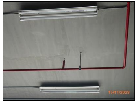
รูปที่ 2.26 ดวงโคม ที่มีแผ่นช่วยสะท้อนและกระจายแสง
