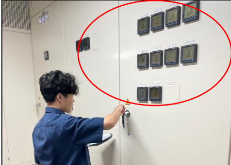
รูปที่ 2.12 ติดตั้งมิเตอร์ไฟฟ้าสำหรับระบบบำบัดน้ำเสีย
